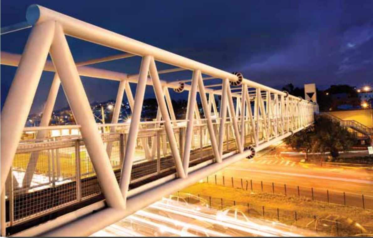
› Passarela - Belo Horizonte - MG
