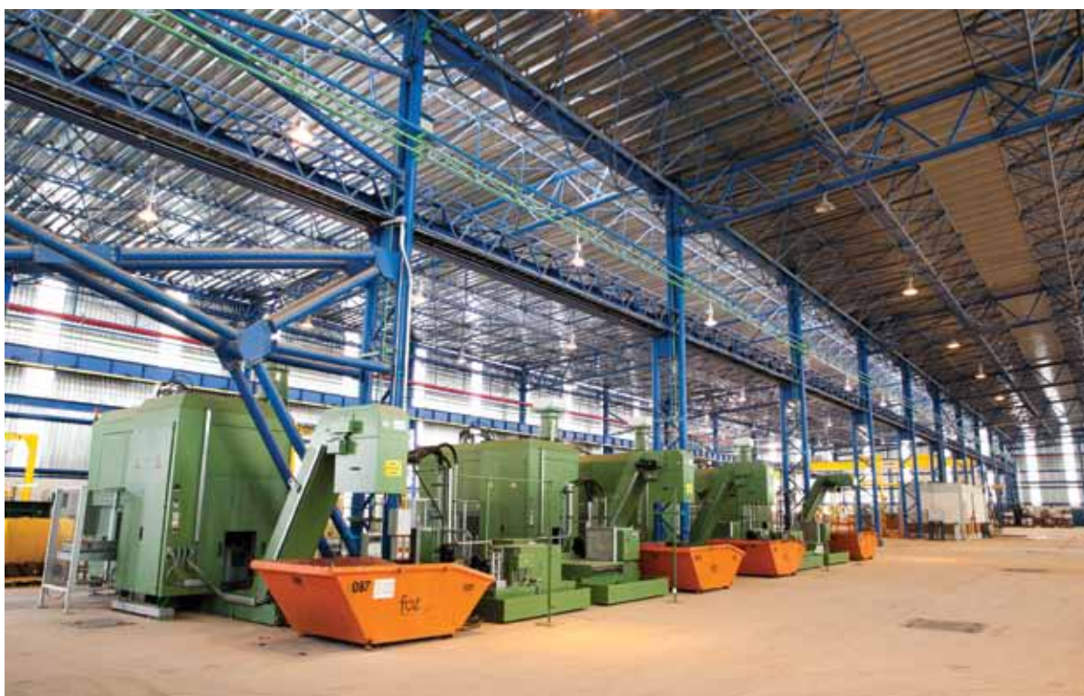
› Sistema de cobertura - galpão industrial
