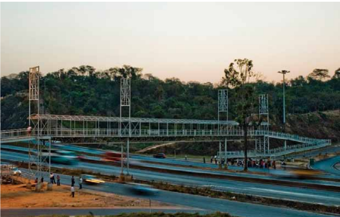
› Passarela - Belo Horizonte - MG
