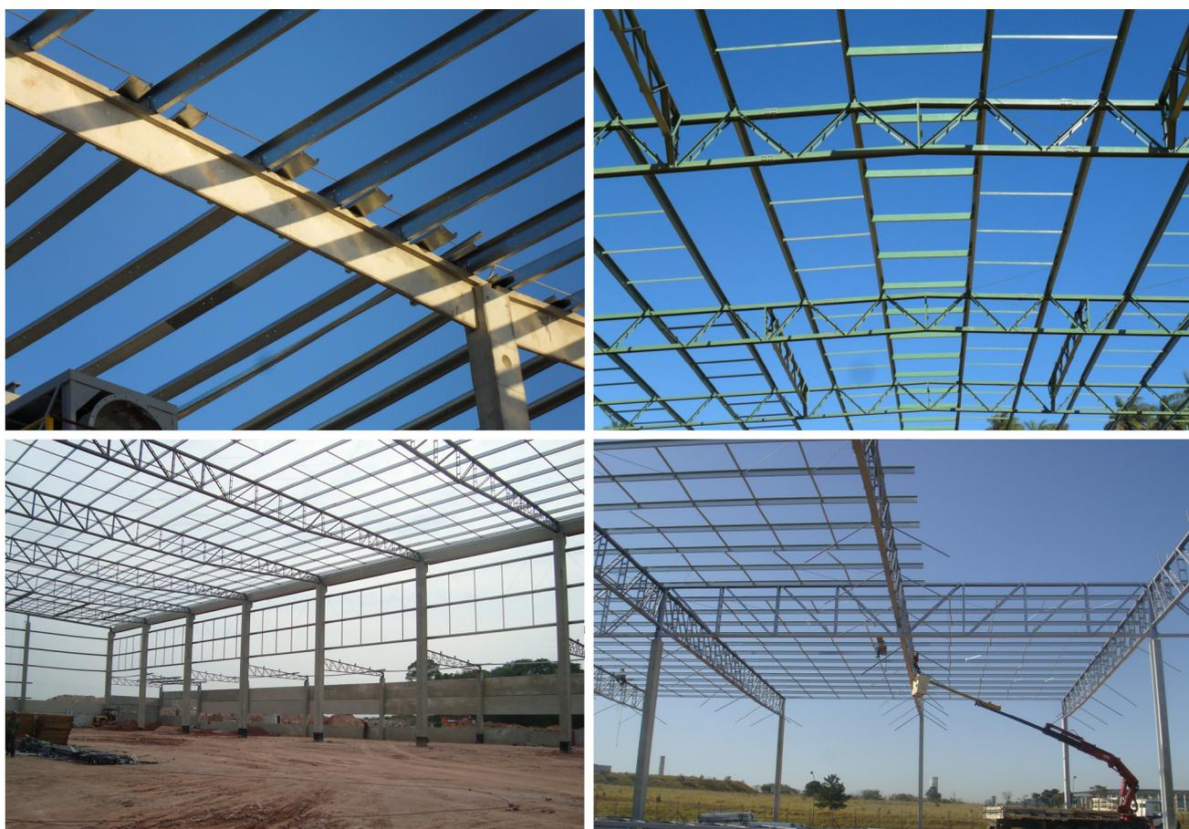
Montagem das terças do Sistema **MODULAR** utilizando material com acabamento zincado e pintado
